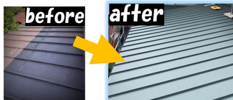
U様邸 瓦葺→立平 ガルバリウム鋼板で丈夫な屋根に！
