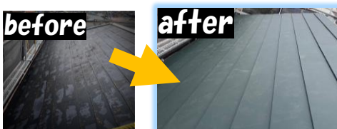
M様邸 カラーベスト→スーパーガルテクト 軽量で高い耐久性を併せ持つ新素材に！
